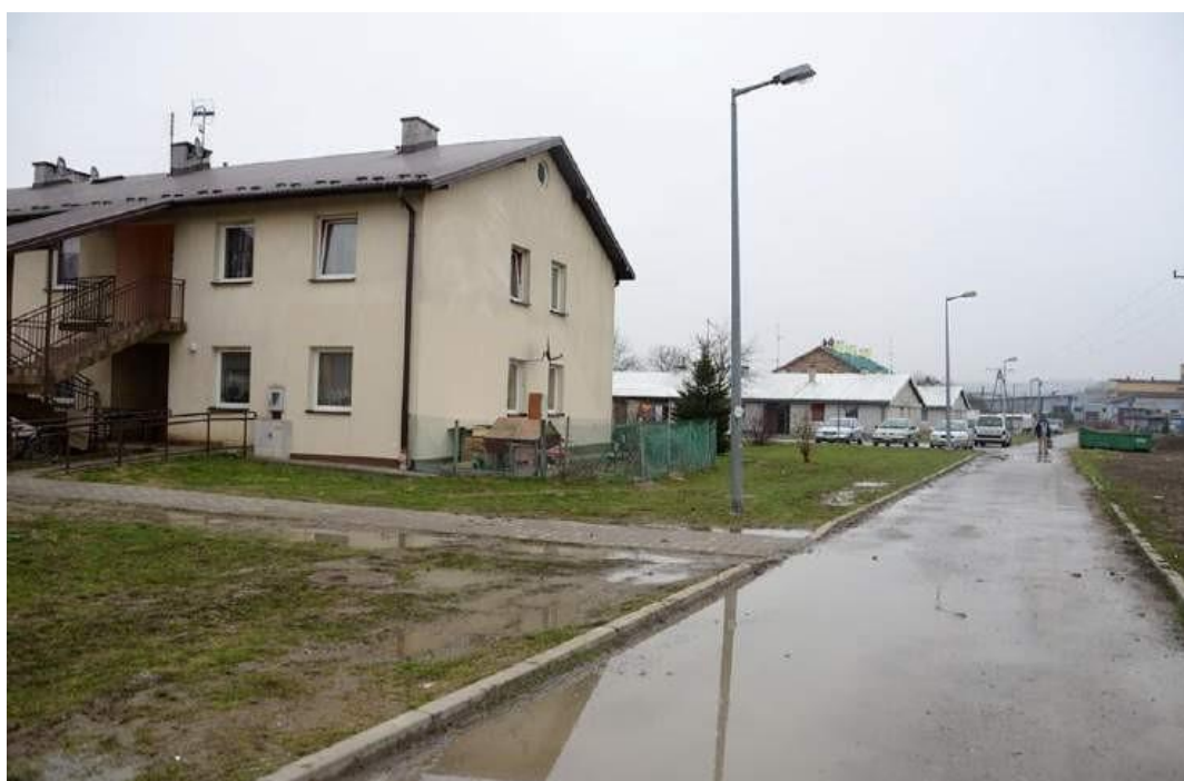
Zdjęcie nr 17 Stan techniczny jednego z budynków Osiedla Socjalnego ul. Na Buczków, fot. Łukasz Chojecki
