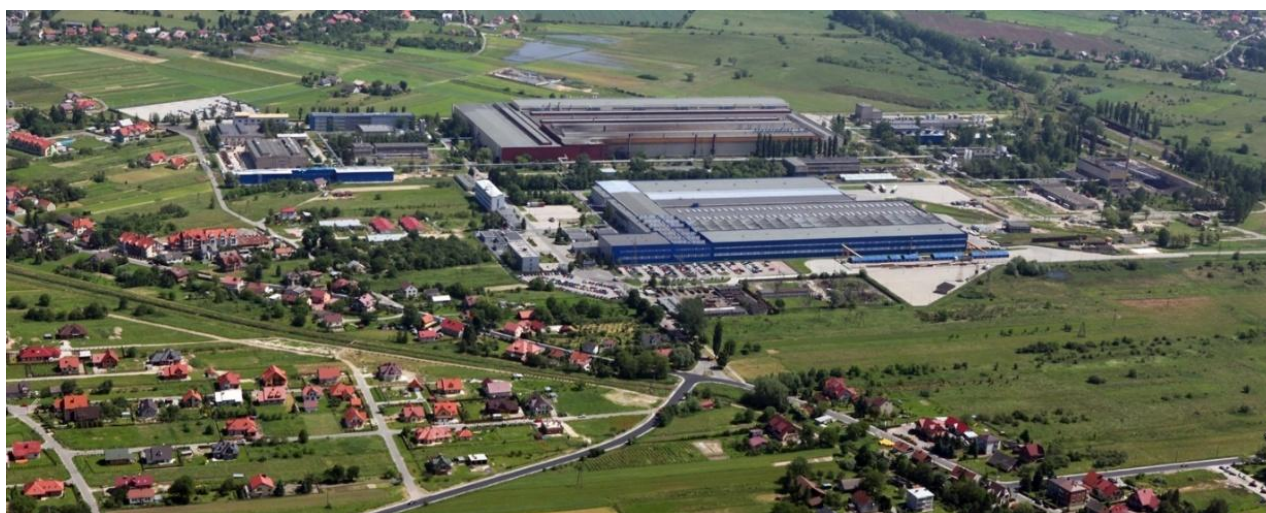
Rysunek 16 Istniejący budynek firmy Stalprodukt S.A.
