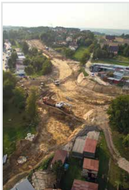
Budowa II etapu trasy północno-zachodniej
