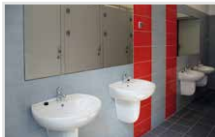
W kilku bocheńskich szkołach wyremontowano sanitariaty
