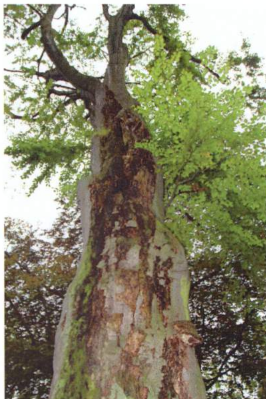
Zdj. 8. Największe uszkodzenie pnia od strony północno - wschodniej (NE).
